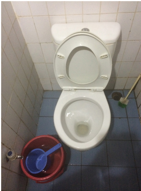
Gambar 27. Toilet duduk dengan sistem pembilas otomatis. Tabung air pembilas terletak di bagian belakang atas toilet
