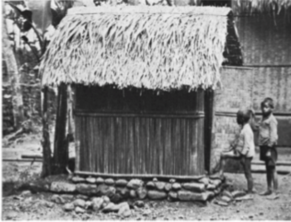
Gambar 6. Model toilet pada propaganda kebersihan Hydrick. Dinding dengan rangka dan anyaman bambu Sumber: Stein (2009:550)
